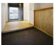
20 玄関ポーチ 磁器質タイル仕上げ
