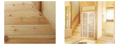
4 天然無垢床材 1階:赤松(節有)30mm 2階:赤松(節有)30mm 5 4寸真壁づくり オール4寸角(120mm) の柱を贅沢に使用した 天然木空間。
