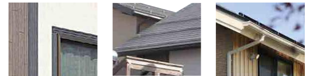
24 外壁 防火サイディング 16mm 25 屋根材屋根工事・ 耐摩カラーGL 26 雨樋
