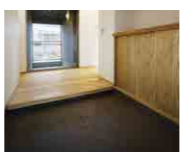
20 玄関ポーチ 磁器質タイル仕上げ
