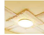
32 照明器具全室
